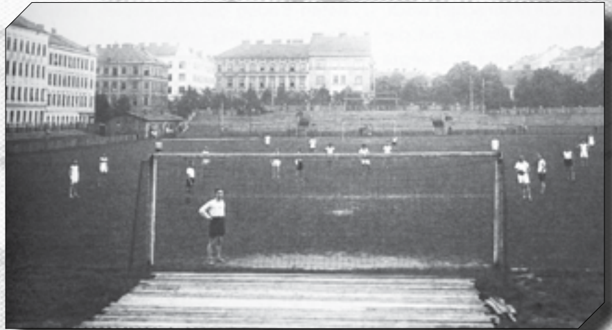
Eine Ansicht des Sport-Club-Platzes aus dem Jahr 1923. Links über dem Kreuzeck ist die Kabinenbaracke zu erkennen.
